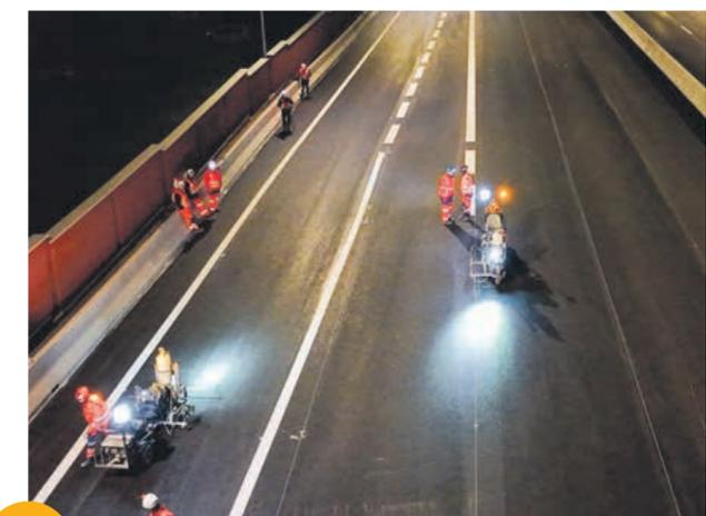
**5** Place au marquage au sol. Après un filet de prémarquage avec vérification de l'implantation topographique, où l'on contrôle notamment la largeur des voies, une nouvelle machine vient peindre les bandes blanches et les tirets constituant le marquage réglementaire.
