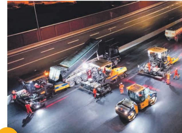
**2** Les camions-bennes viennent alimenter les finisseurs. La plateforme autoroutière étant très importante (15 à 20 m de large par sens), plusieurs finisseurs avancent en parallèle, en léger décalage, pour couvrir l'intégralité de la chaussée. Ils sont alimentés par un ballet de camions amenant l'enrobé chaud.
